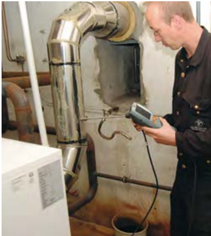
Der Schornsteinfeger prüft und kontrolliert, ob Heizung und Schornstein zusammenpassen.
