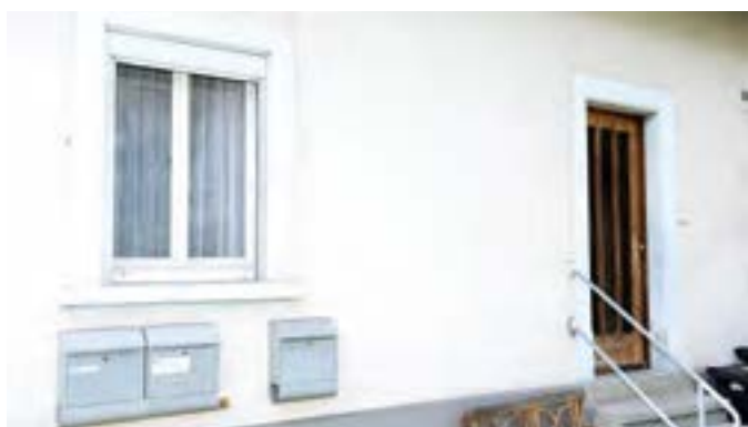
Ganzheitlich sanieren: Wird die Fassade erneuert, ...
