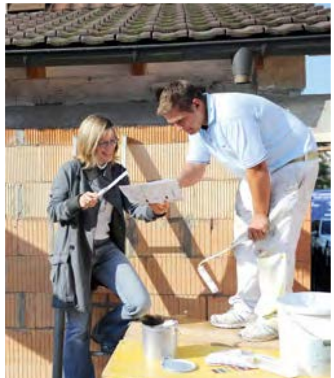
Planer, Ingenieure und Handwerker arbeiten bei der Sanierung effektiv zusammen.
