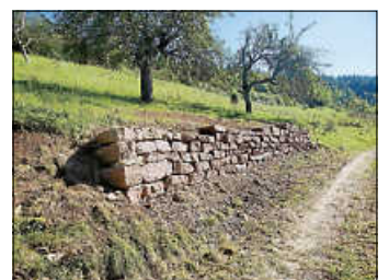
Trockenmauer nach der Sanierung in Wildberg Fotos: Landschaftserhaltungsverband Landkreis Calw e. V.
