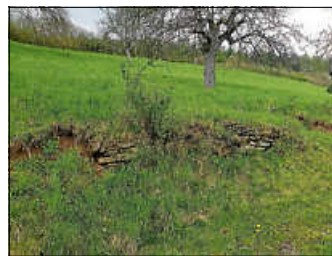
Trockenmauer vor der Sanierung in Wildberg
