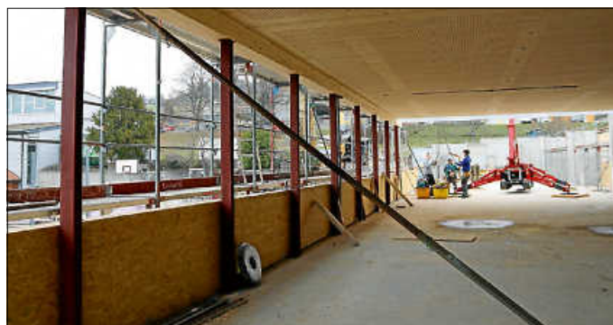
Decke und Wände im Neubau
