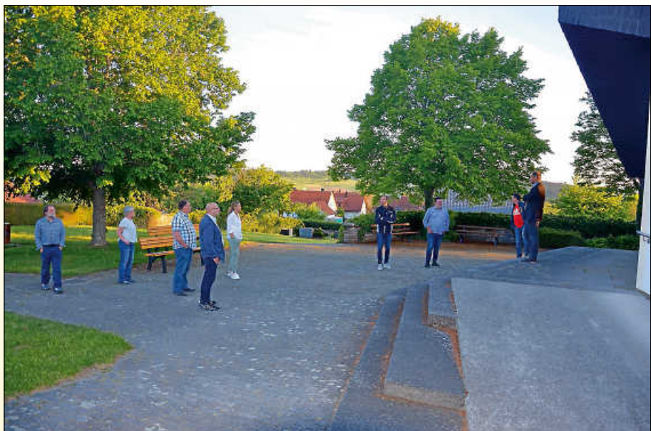
Das Dach der Aussegnungshalle ist undicht
